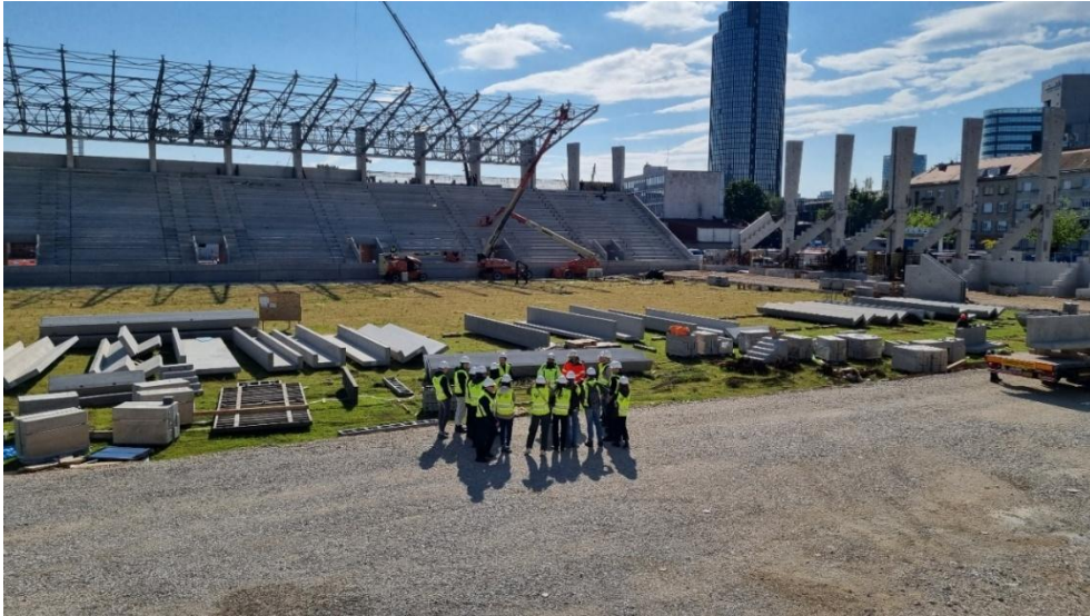
Na desnoj strani fotografije vide se postavljene stupovi i nosači buduće južne tribine, na gornjoj lijevoj strani fotografije nalazi se istočna tribina s postavljenim krovom, dok se na travnjaku nalaze predgotovljeni uzdužni elementi.
