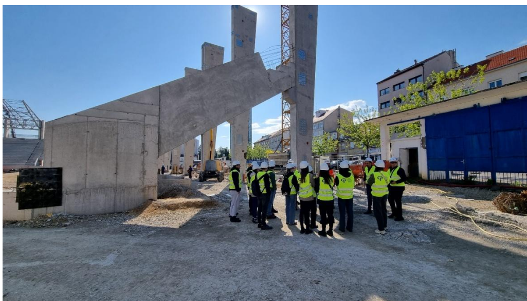
Betonske tribine od predgotovljenih betonskih elemenata. Na stupovima su već u proizvodnji ugrađeni vijci za montažu krova.
